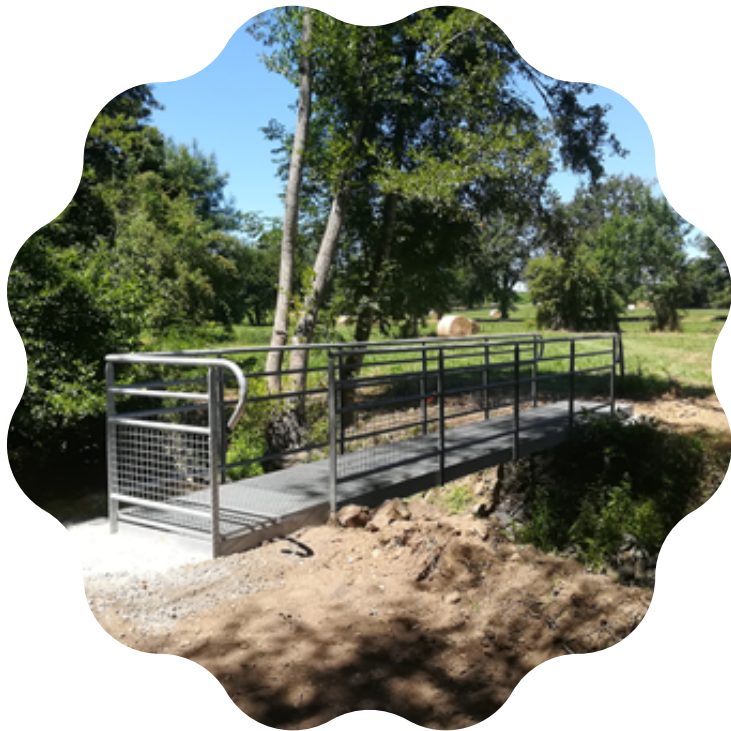
Passerelle permettant la traversée de l'Hière
